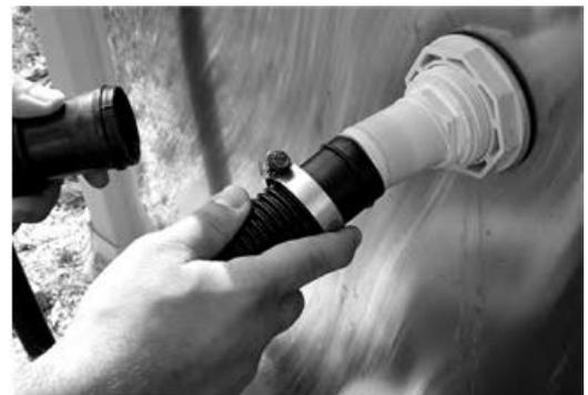
8. Raccorder le tuyau fourni à la sortie opposée, coté retour vers la piscine et connecter l'embout sur la buse de refoulement, serrer le collier.
