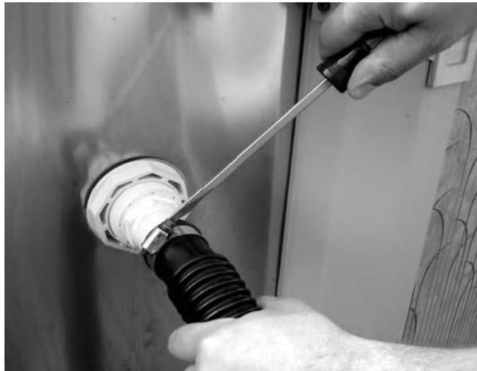
7. Retirer le tuyau de la buse de refoulement et connecter l'embout sur l'adaptateur coté arrivée du filtre, serrer le collier.
