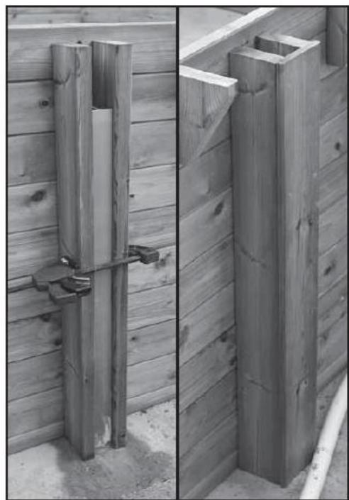
**4** • Préparation des parois • Vorbereitung der Seitenwände • Voorbereiden van de wanden
